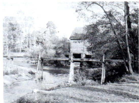
L'ancienne passerelle du moulin Bavard
